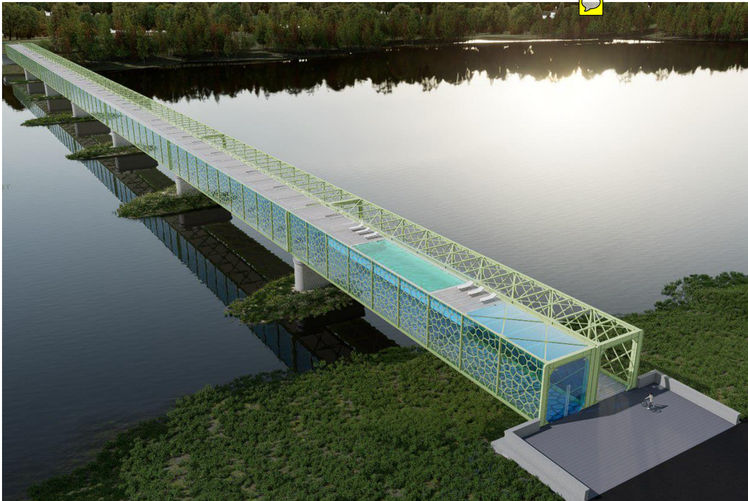
Le Viaduc Ferroviaire de Sully & Saint Père-sur-Loire
